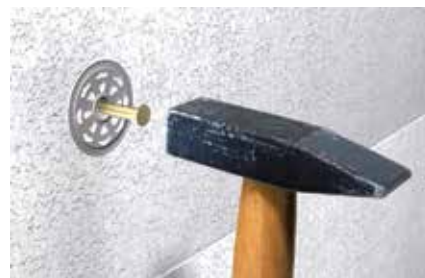
Installazione del fissaggio a percussione su pannelli in schiuma rigida di polistirene
