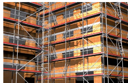
Ponteggio per facciata
